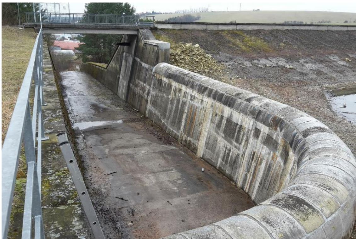
Obrázek 3 - Fotografie současného stavu přelivu a spadiště
